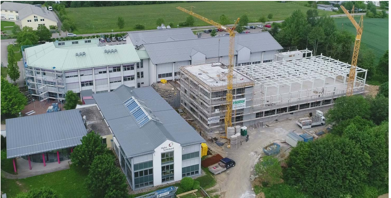
Neues Büro- und Technologiegebäude (Quelle: Hahn-Schickard)
